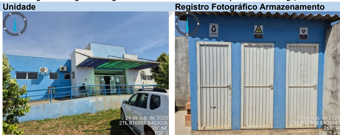
Figura 26. Registro Fotográfico Unidades de Saúde Município de Paranatinga/MT.
